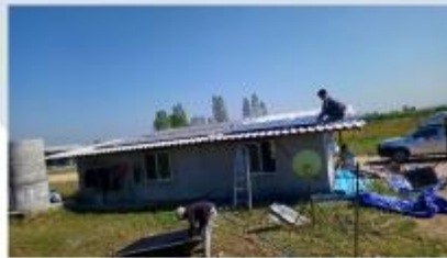
บ้านคนงานในไร่ จ.กาญจนบุรี ขนาด 5 kW
