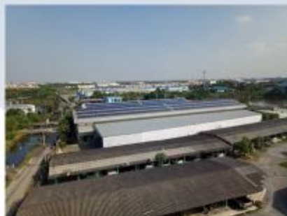
พุทธมณฑล สาย 5 ร.ง. AST ขนาด 225 kW
